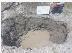
FOTO 2. Vista de la excavación.
